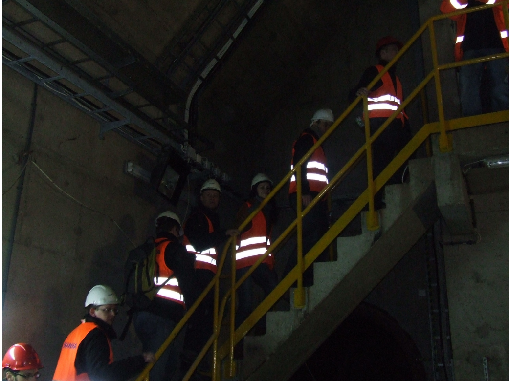
Zdjęcie 8: Przejście sztolnią do wieży ujęciowej
