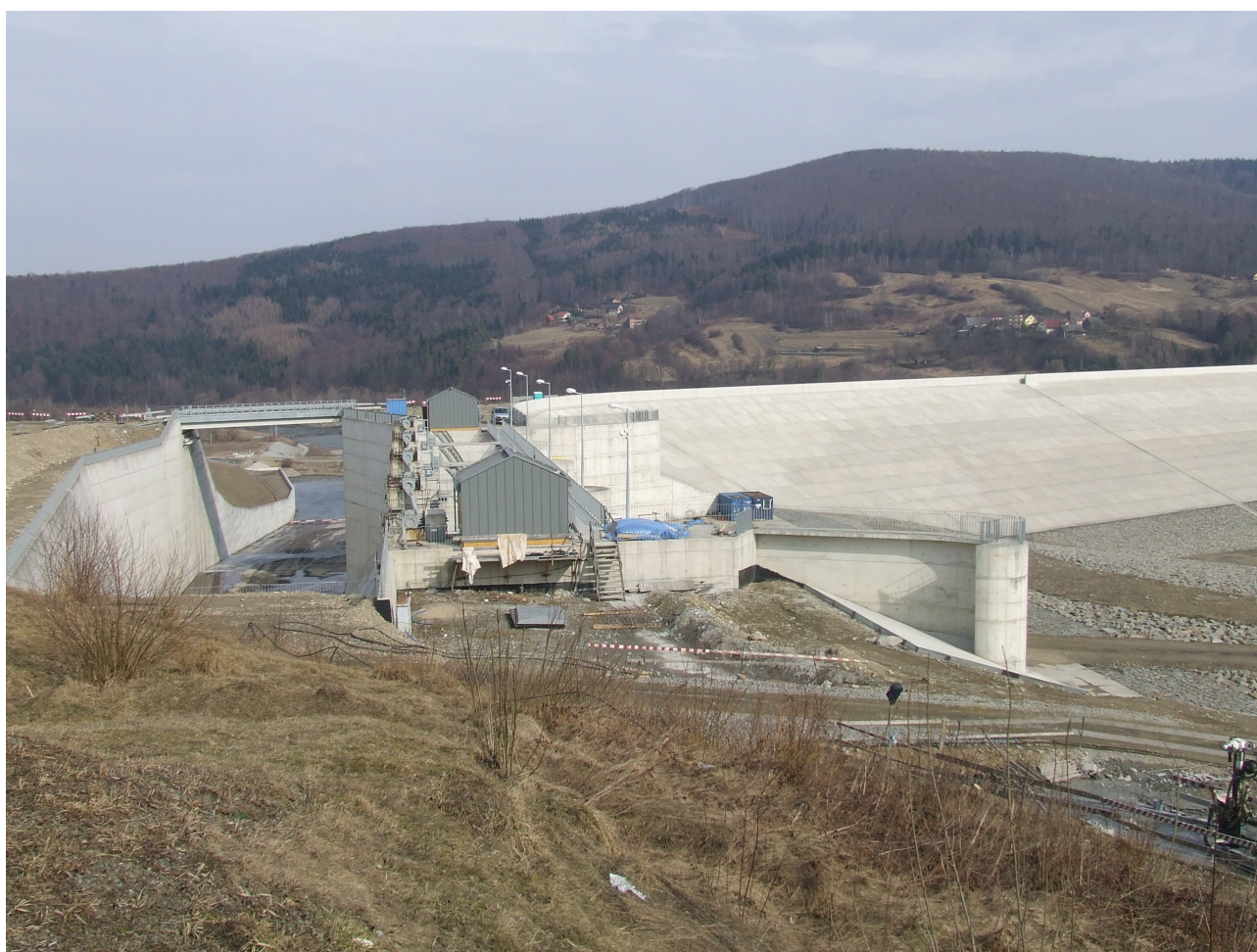
Zdjęcie 5: Widok na przelew i zaporę
