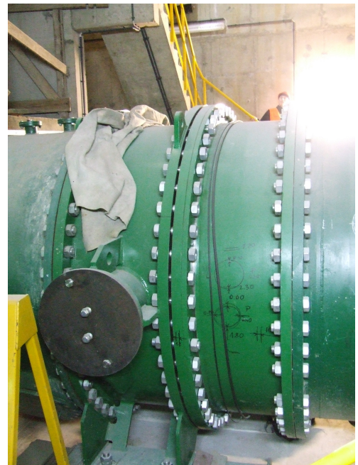
Zdjęcie 9: Połączenia śrubowe rury w sztolni
