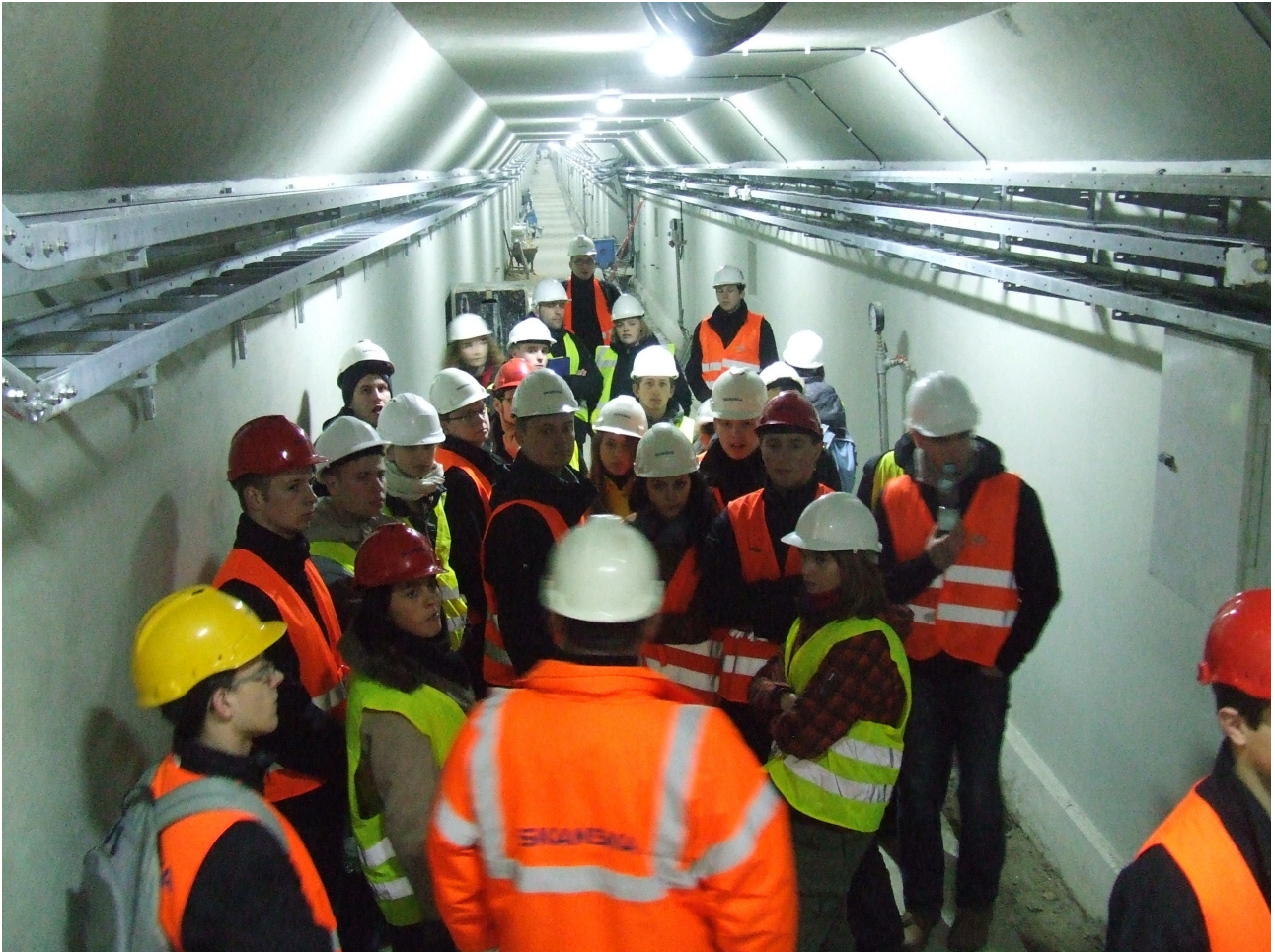
Zdjęcie 6: W "bunkrze" - galeria pod zaporą
